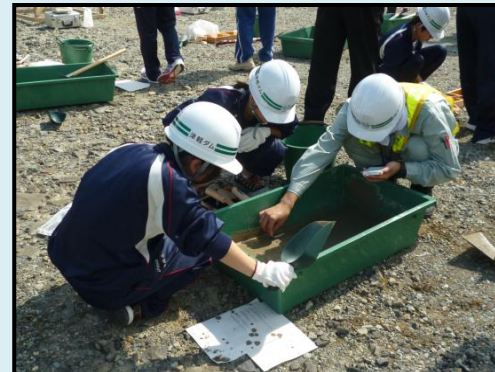
〔コンクリートpH測定〕
