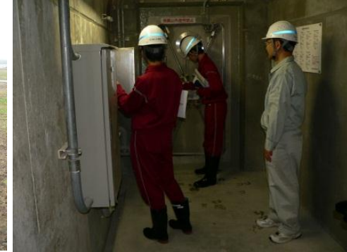
〔さみだれ大堰 監査廊 点検体験〕
