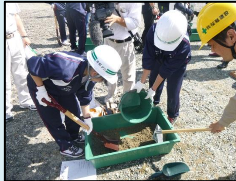
〔コンクリート練り混ぜ〕
